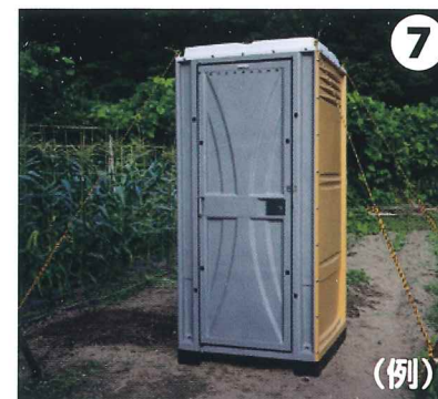
⑦ 完成したトイレハウスが倒れないようにロープ等で固定します。 ※ロープはついておりません。現場でご用意してください。
