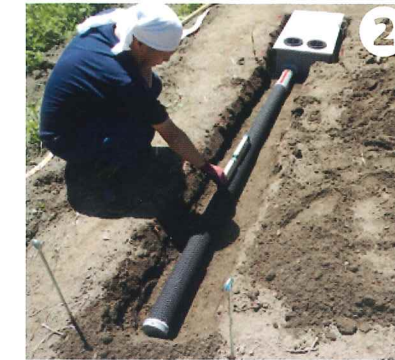
② 便槽の穴とトレンチパイプの溝を掘り、設置し、つなぎます。トレンチパイプが水平になっているか確認します。
