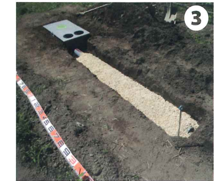
③ トレンチパイプの上に浸透促進剤をまんべんなく入れます。
