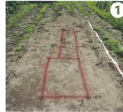
① 設置場所を決めます。穴掘りの位置を決めます。
