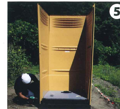
⑤ 床パネル、壁パネル、屋根の順でトイレハウスを組み立てます。
