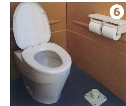
⑥ 洋式便器を取り付けます。次に足踏みポンプとペーパーホルダーを取り付けます。
